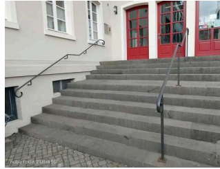
Treppe im Haupteingang
