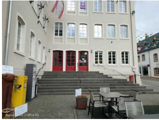
Treppe im Haupteingang
